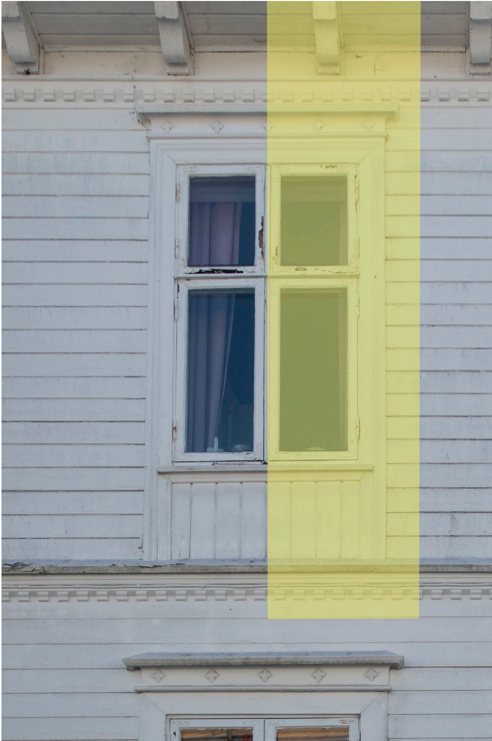
Figur 30 Forslag til referansefelt (markert med gult). Eldre maling skrapes ikke vekk på referansefeltet, men overflaten vaskes grundig og males over. Valg av referansefelt avhenger av at eldre maling har god vedheft og må plasseres deretter.
