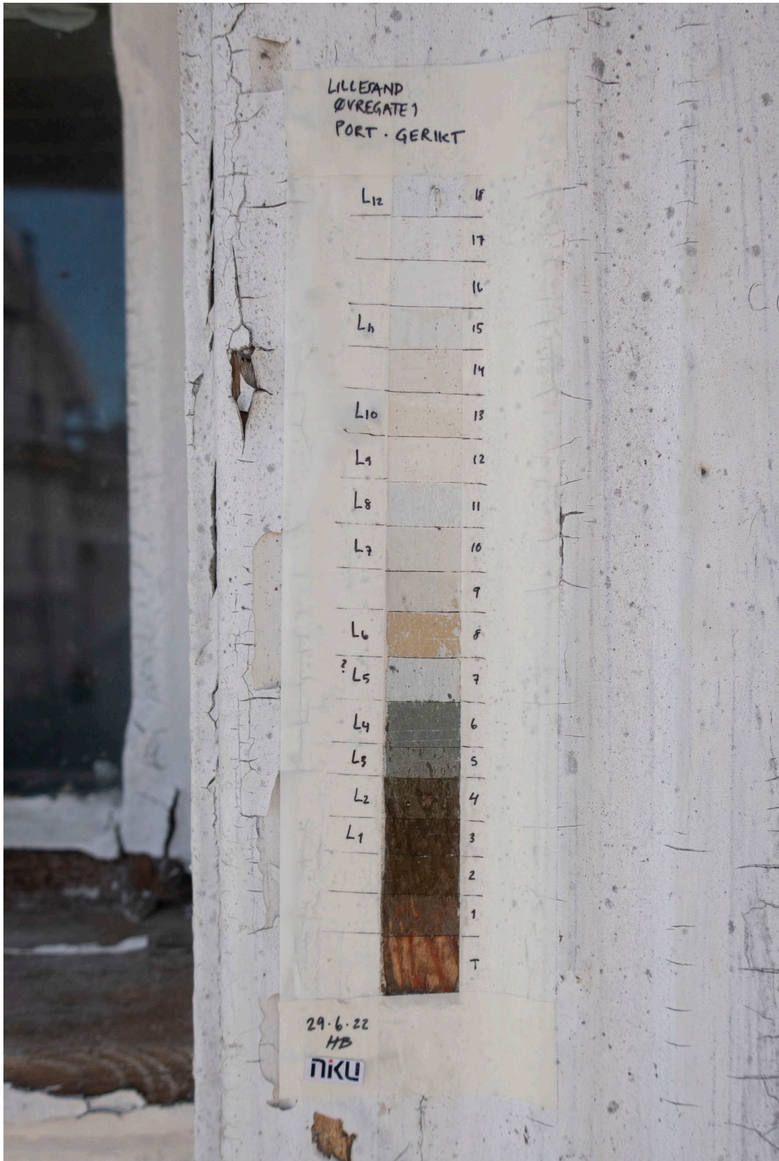
Figur 20 Lagvis avdekking på portgeriketen. Avdekningen er laget på nordre sidegerikt, ved siden av overlysvinduet. Foto: NIKU, 2022.
