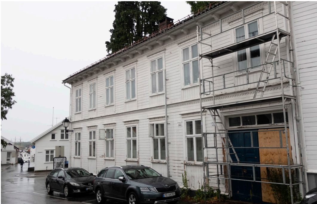
Figur 1 Østvendt langfasade. De tre nordligste vinduene i 1. etasje, samt tilstøtende panel er nyere. Foto: NIKU, 27.06.2022.
