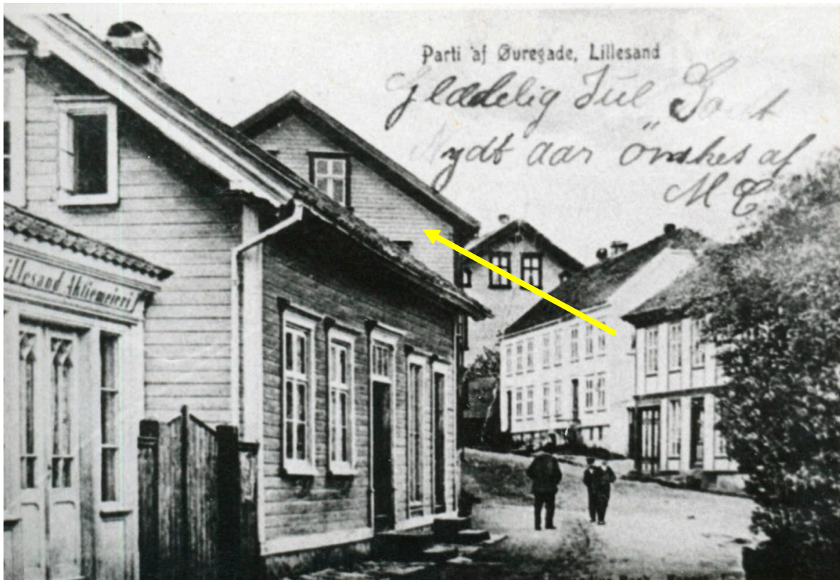
Figur 8 1906 Gavfasaden i Øvregate 1, markert med gul pil. Lyse vindusrammer med mørke omramninger og takutstikk. Kilde: Agdebilder.no. 3
