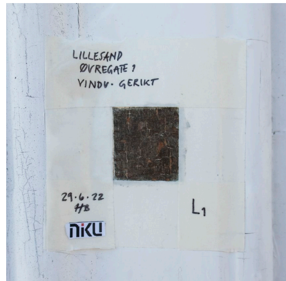
Figur 27 Større avdekning av første farge på vindusgerikt. Foto: NIKU, 2022.
