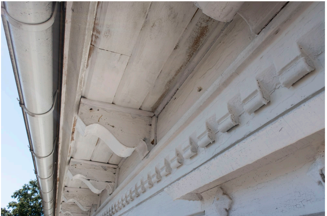
Figur 4 Utskjærte taksperrer mot øst. Bordene under takutstikket er nyere. Foto: NIKU, 29.06.2022.
